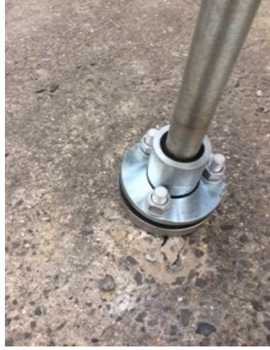
設置不可コンクリート②
