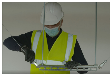
日本建築センター評定取得 B種耐震振れ止めワイヤ工法
