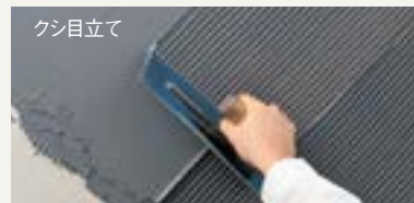
タイル張り付け
