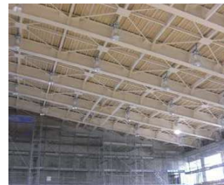
体育館 鉄骨梁
