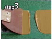
必要に応じて下塗りした後、ゴムへ ラ、ハケ、ローラーなどでパターンが 完全に隠れるように、塗料を平滑に 塗り広げます。厚塗りし過ぎると、ひ び割れが起きるのでご注意ください。
