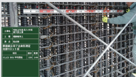
鉄筋の撮影に
