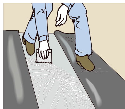
●ビニル床シートの施工に
