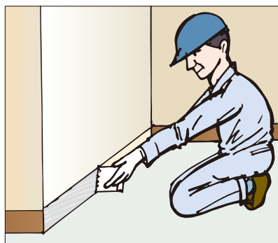
●ソフト巾木・ワイド巾木の施工
