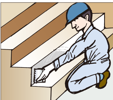
●階段の立ち上げ、ササラ巾木の施工
