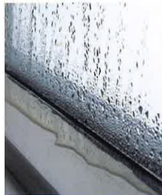
木製窓枠の劣化防止に
