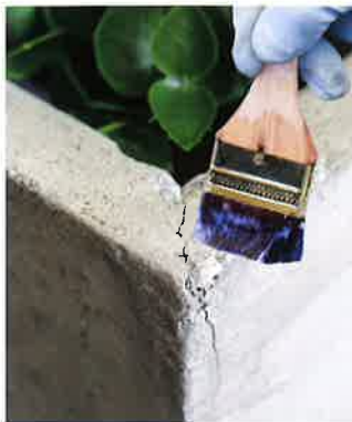
プランターの亀裂に
