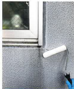
壁のひび割れに
