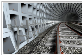
例：トンネル内の 取付け
