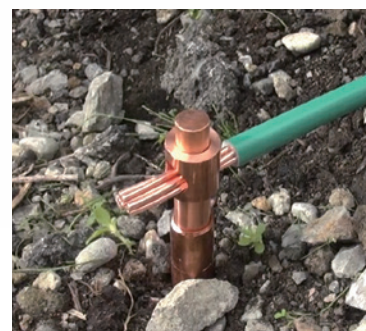
3 埋め戻して施工完了
