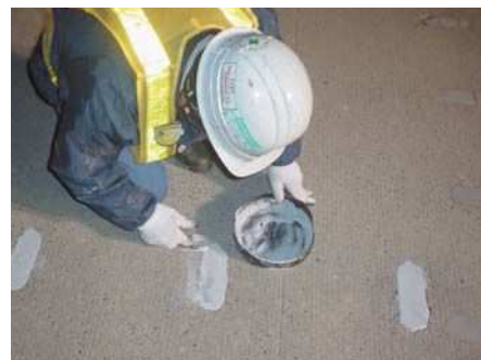
▲ホーンジョイントの跡埋め材として、コールミックスグレーを使用
