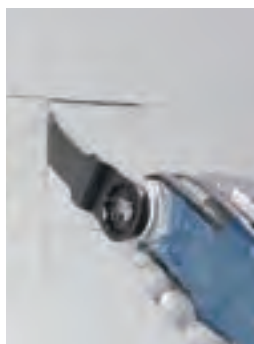
配管設備開口
