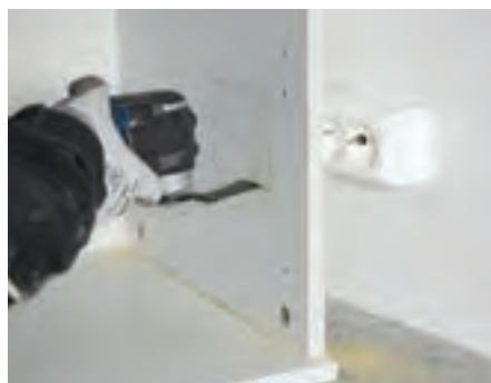
コンセントボックス開口
