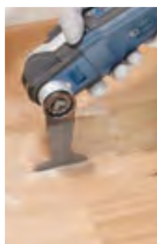
フローリング開口
