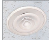
天井吹き出し口 (丸) (直径 500~830mm)
