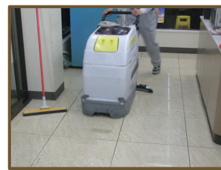
床洗浄機による仕上げ
