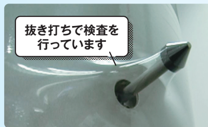
突き刺し試験機による計測
