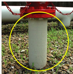
消火栓地際部
