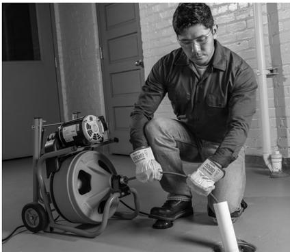
図 10 - ケーブル引出口から2フィート(0.6 m)以内になるように排水管の入口を延長した例
