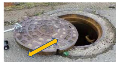
\* マンホールの蓋が重くて上がらない場合は決してハンドルを無理に押し下げ荷重をかけないでください、破損の原因となります。(耐荷重は100kgです)
