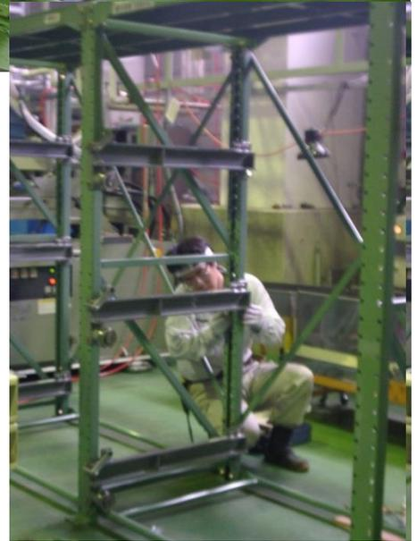
6. 水準器でレベル測定後、レベル調整ライナーをベースプレート下に入れる。
